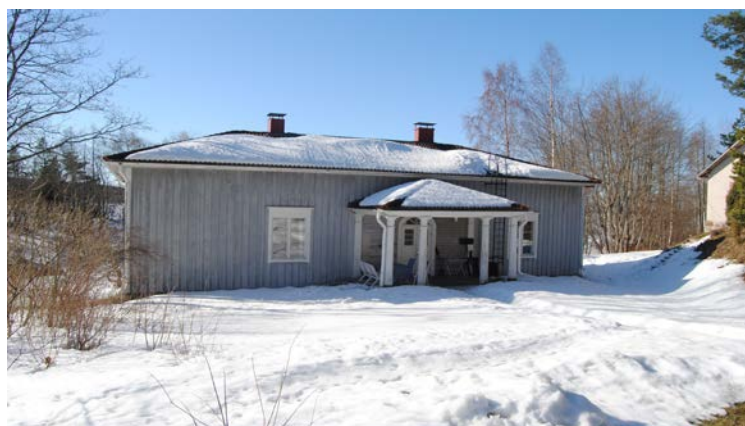
Asuinrakennus pohjoisesta kuvattuna.
